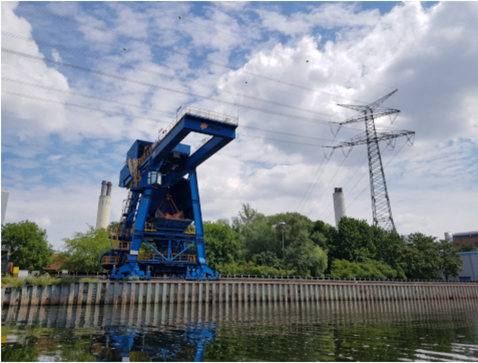
Der Bagger bzw. Kran gehört vermutlich zum Heizkraftwerk Reuter West
