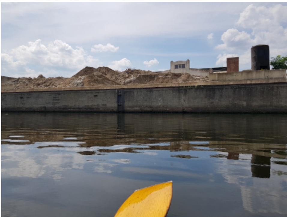
Abrissarbeiten auf Sophienwerder
