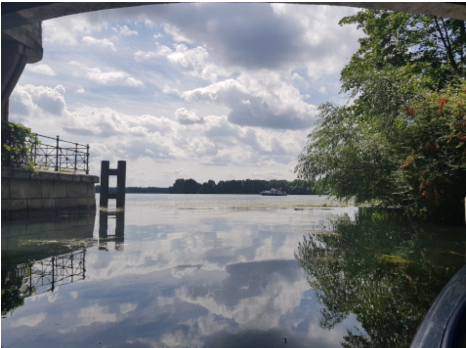
Tegeler Hafenbrücke mit Blick auf den Tegeler See
