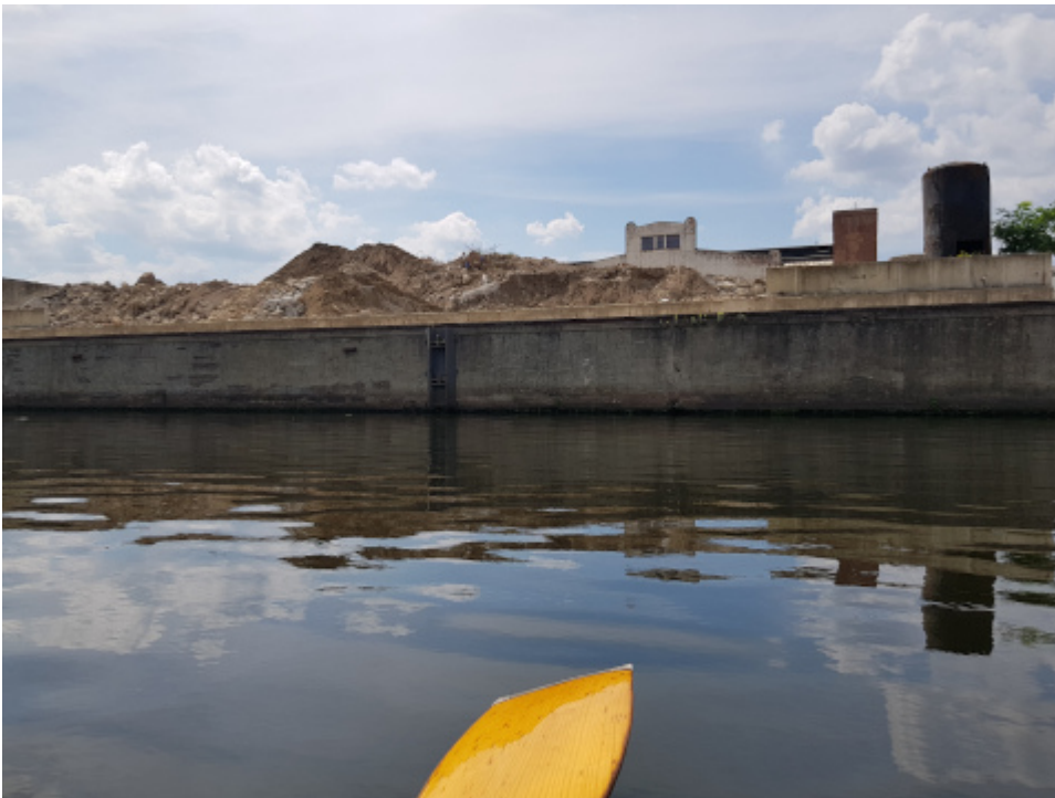
Abrissarbeiten auf Sophienwerder
