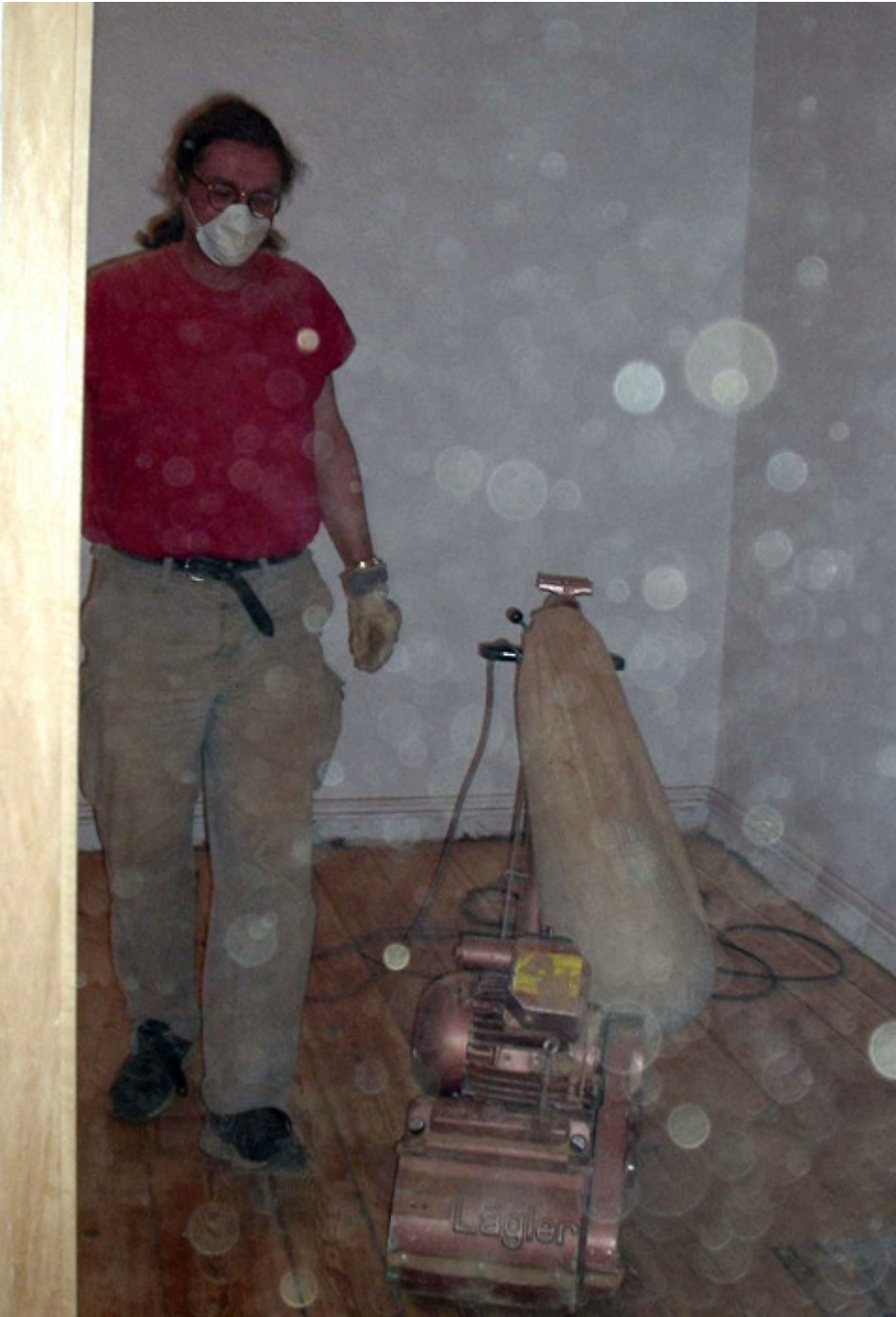
Fußboden bei einer Freundin abgeschliffen. Motto: Einmal mal richtig einsauen... (18.3.2004)
