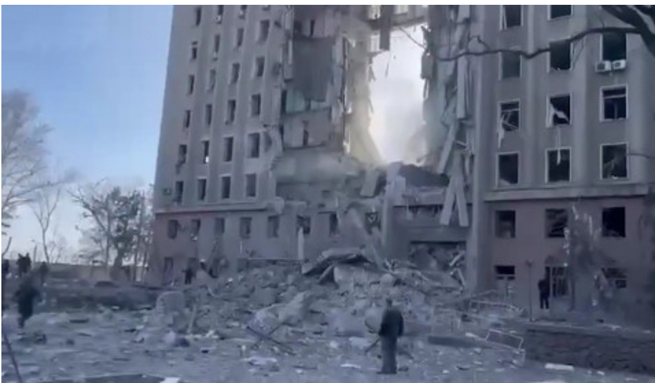
Ein zerstörtes Verwaltungsgebäude in Mykolajiw
