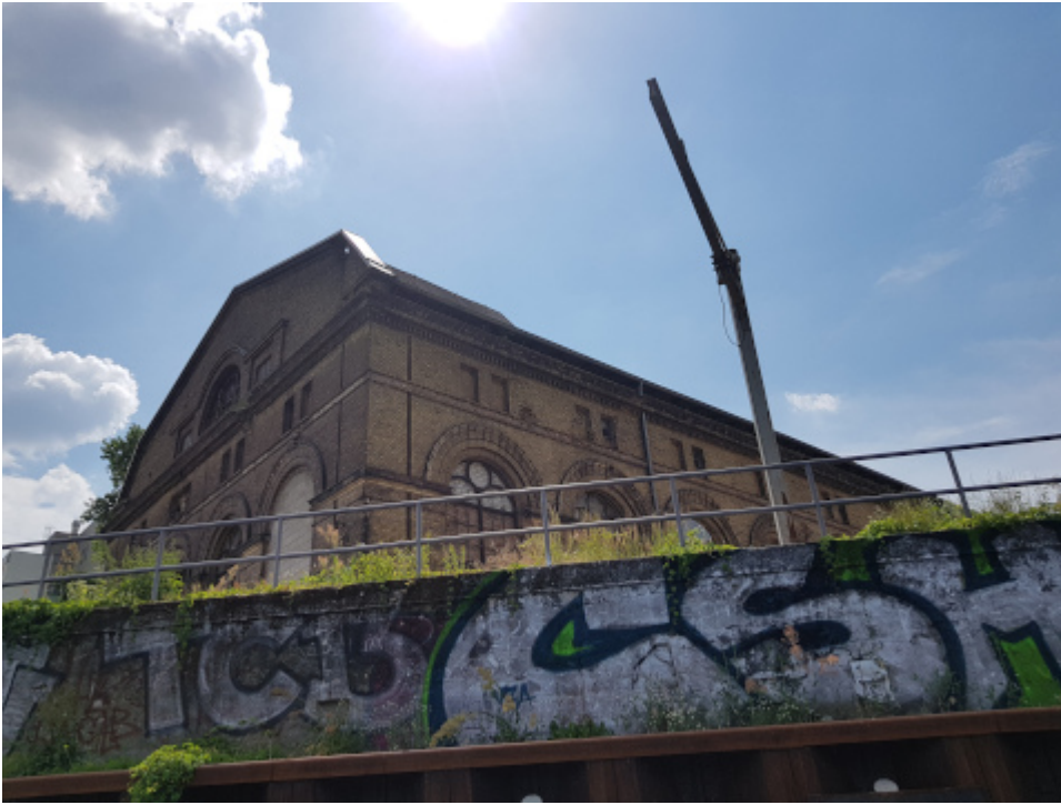
Industrieruine in Strelow, an der Mündung der Spree in die Havel
