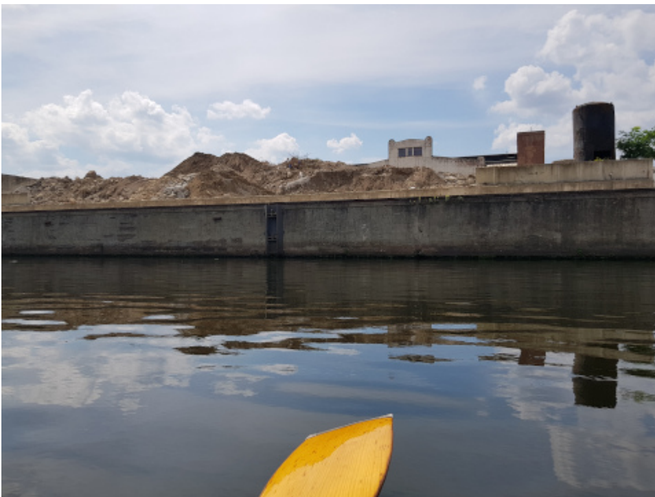
Abrissarbeiten auf Sophienwerder
