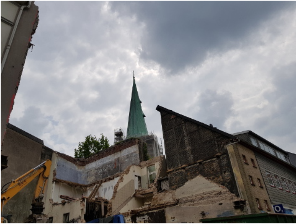
Abbrucharbeiten Bahnhofstraße Unna
