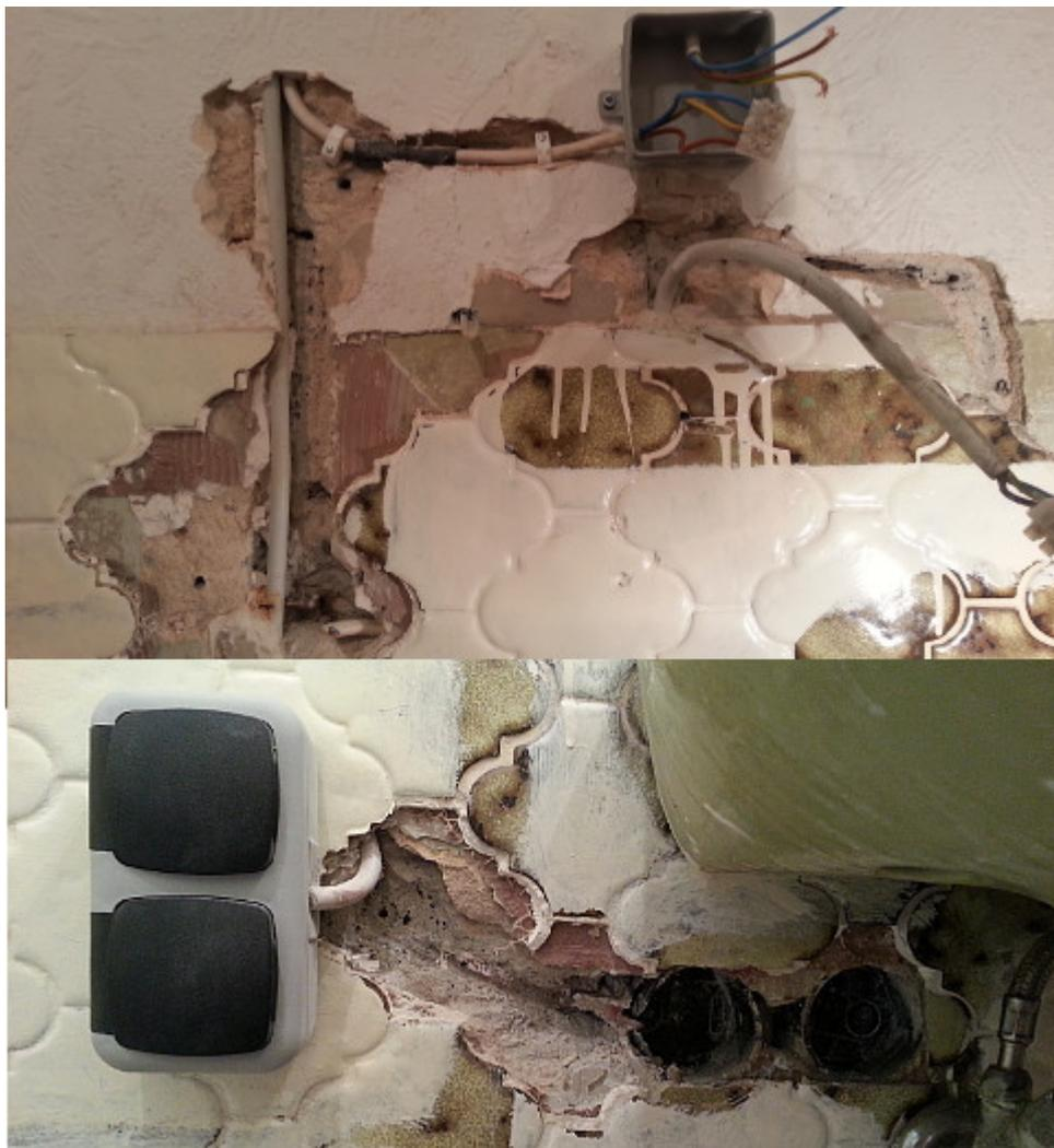
Vier Feuchtraumsteckdosen angebracht, die alten (Museum für Verkehr und Elektrik der 70-er Jahre) entsorgt, neue Verteilerdosen angebracht, und Leitungen verlegt bzw. selbiges vorbereitet. Dübellöcher habe ich gar nicht mitgezählt. (Mach Spaß, durch Kacheln zu bohren. Freut die Nachbarn.) Heute Nachmittag werde ich wohl die neue Lampe anbringen.
